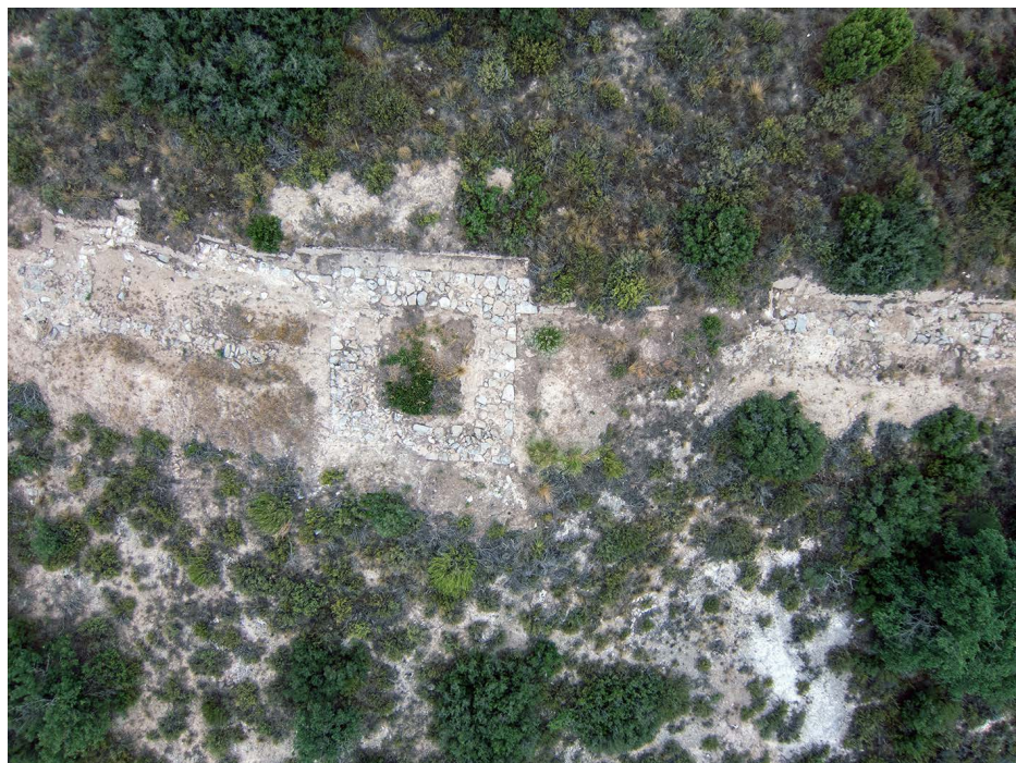
Figura 9. El tram central de la muralla sud, amb una de les seves torres (Equip Puig Castellar).
