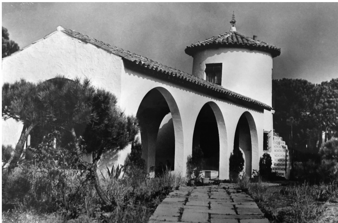
Figura 8. Edificio de baños en Gavamar. Ramon Tort, 1948. Arxiu Històric del COAC.
