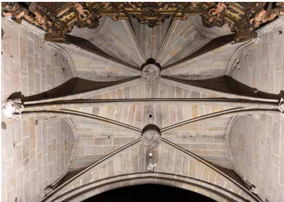
Figura 9. Bóveda de la capilla del Salvador (arriba). Clave con la Trinidad (abajo). Fotos Robert Ramos © Catedral de Barcelona —derechos reservados—. Prohibida la reproducción total o parcial.
