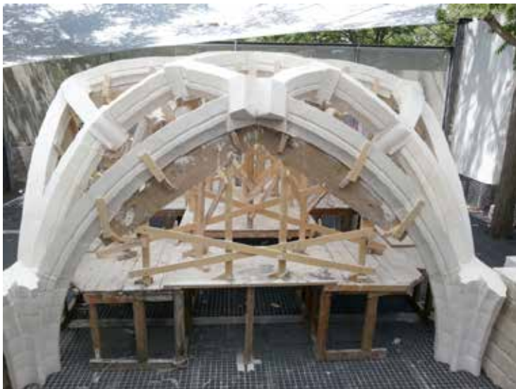
Figura 24. La bóveda ya terminada sobre su cimbra.
