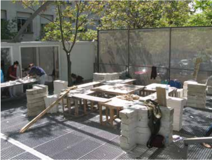
Figura 21. Las plataformas de trabajo de la bóveda.
